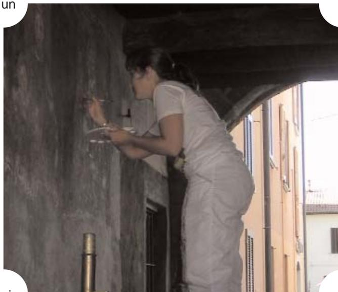
modo da conservare integri, ove possibile, materiali e strutture. I distacchi, di notevole entità, sono stati fissati e consolidati con iniezione di malte a calce idraulica naturale previo fissaggio e riadesione dell'intonaco al supporto. Il restauro pittorico è stato realizzato ad acquarelli con tecnica a rigatino per le piccole lacune, a tono neutro per le lacune importanti ed è stato compiuto un consolidamento finale.
